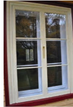
Fenêtre avec châssis intérieurs et contre-fenêtre datant d'environ 1850. ©Clément Locat.
